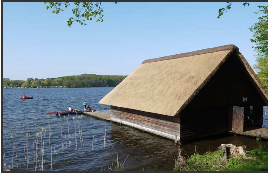
Das frisch sanierte historische Bootshaus am Ratzeburger See. Foto: Anders
